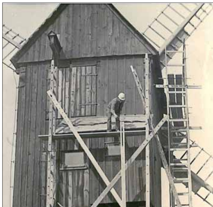
Mühle Lebusa, Reparaturarbeiten
